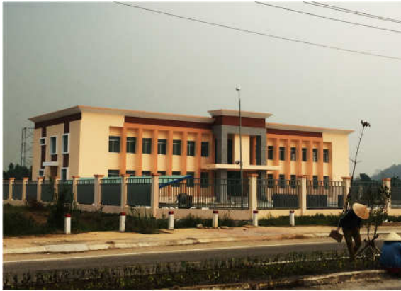
Trụ sở UBND thị trấn đối diện dự án.
