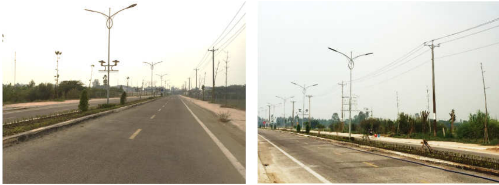
Hình 8: Hình ảnh tuyến đường tránh đã xây dựng.
